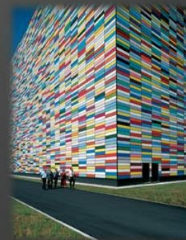
Kraftwerke in Modulbauweise
