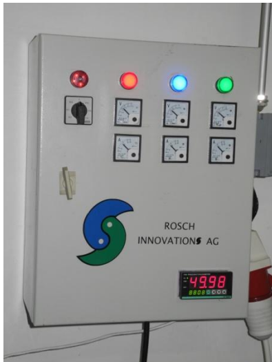
Abbildung 8 Generator Schaltschrank
